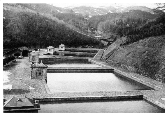
■ 機能拡張により五号ろ過池を増設（昭和4年）
