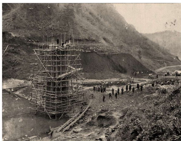
■ 決壊前のダム取水塔の建設(大正2-4年)
