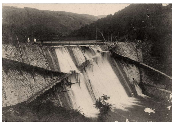
■ コンクリートダム建設の様子(大正8-11年)
